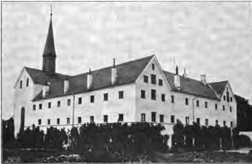
Bild 107. Das Noviziatskloster Laufen nach dem Brande 1887.
